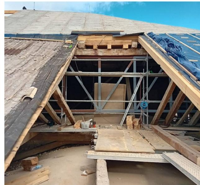
Debido al mal estado en que se encuentran los elementos estructurales de las cubiertas, se ve necesario continuar con los trabajos de consolidación de manera ininterrumpida, al menos de la primera y tercera fase (nave principal y laterales). Una paralización de los trabajos en el tiempo podría provocar el colapso y derrumbe de las zonas no rehabilitadas.
