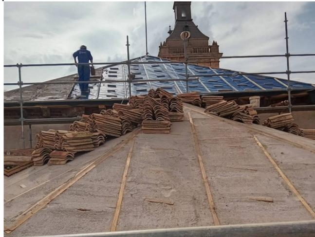
Una vez levantadas las tejas y entablamentos de las cubiertas, se ha venido comprobando que el estado real de deterioro y precariedad de los elementos de madera que conforman las estructuras es considerablemente mayor del que la inspección visual desde el bajo cubierta permitía discernir. Esto obliga a cambiar la mayoría de los pares.
